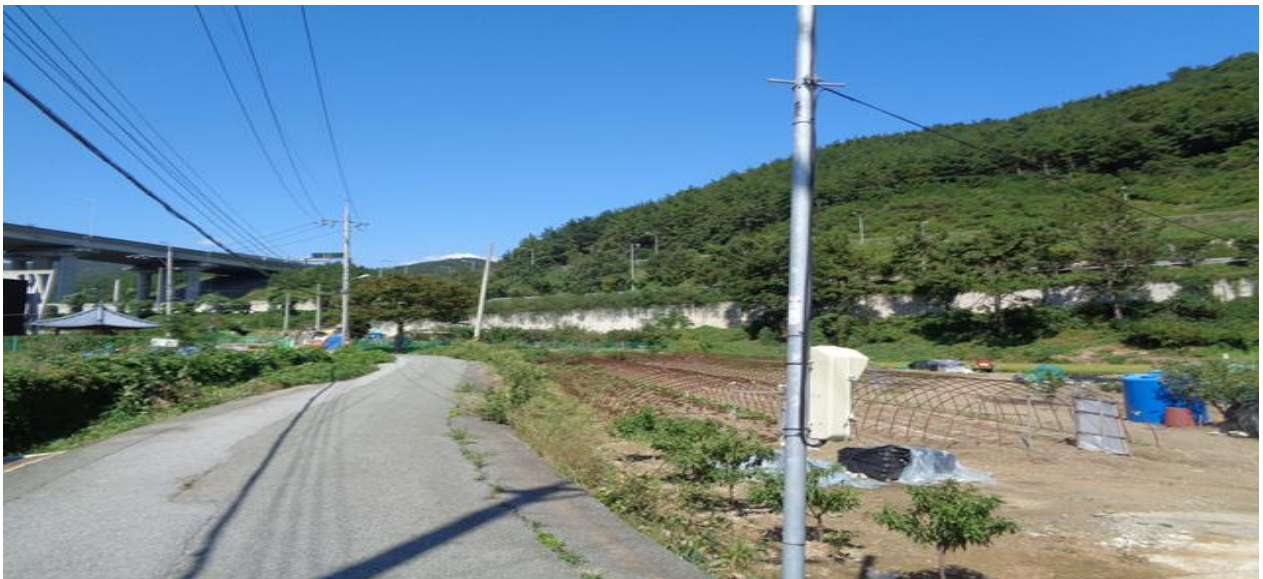
대상 옹벽 전경
